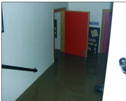
El agua alcanzó en el interior 1,40 m. de altura.
